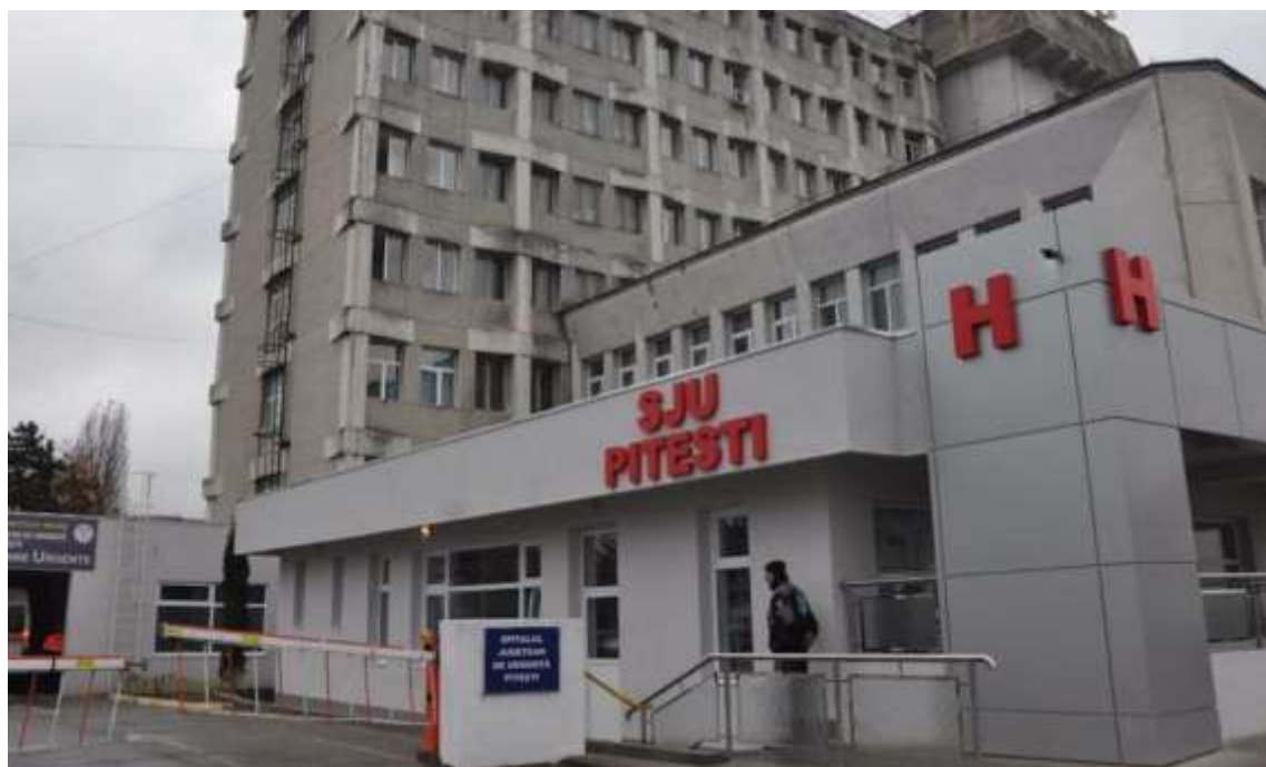
Fig. 28 Clădirea Spitalului Județean de Urgență Pitești
